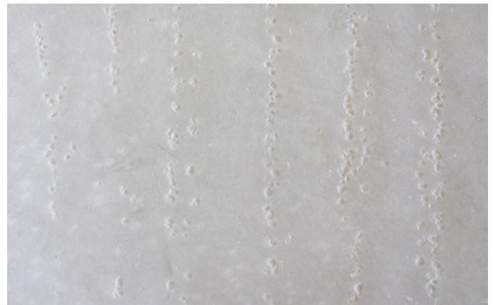
Abb. 25: Beispiel für die Bläschenbildung an der Oberfläche von Fließestrichen
